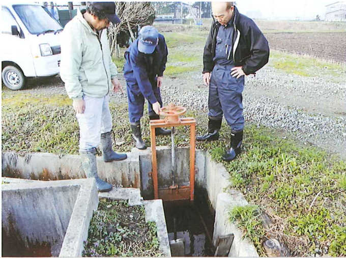
施設の点検 (小荒川)
