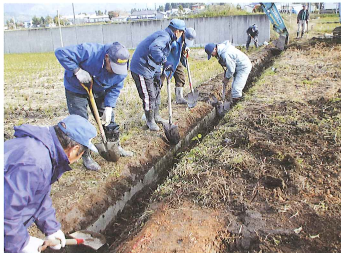
水路法面補修（畑屋）
