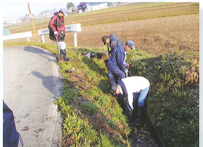
水路の泥上げ (千屋南部)
