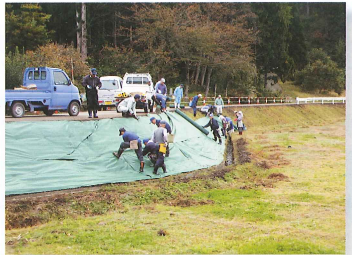
防草シートの貼り付け (千屋中部)
