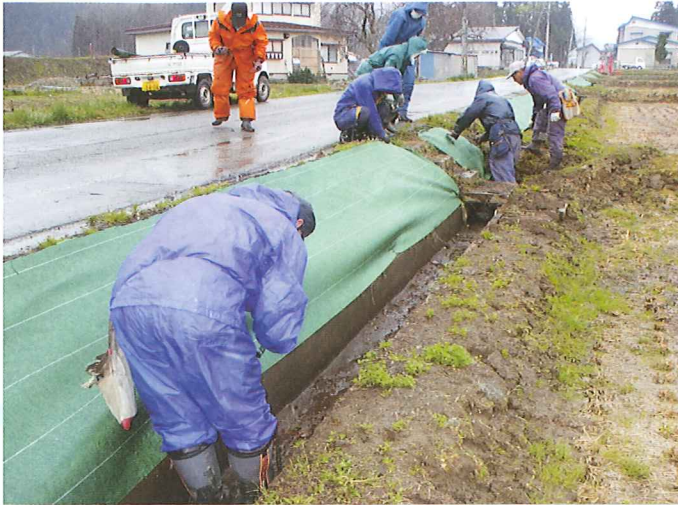
防草シートの貼り付け（善元寺）
