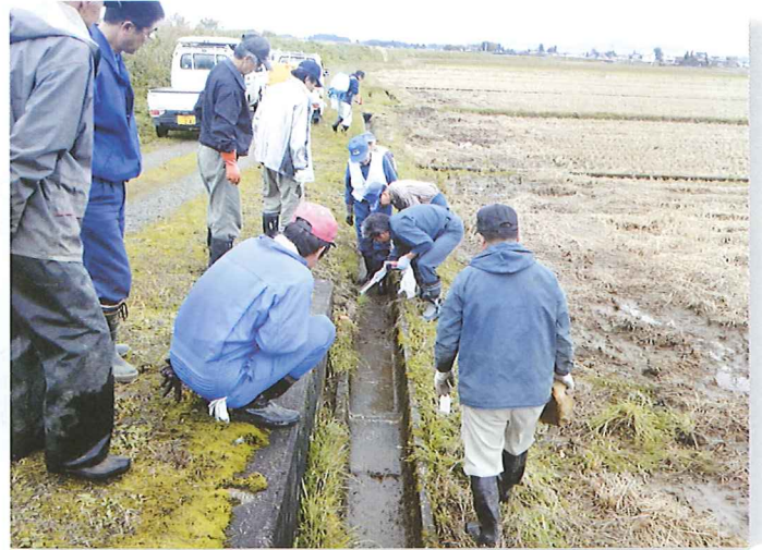
水路の目地補修（大畑）
